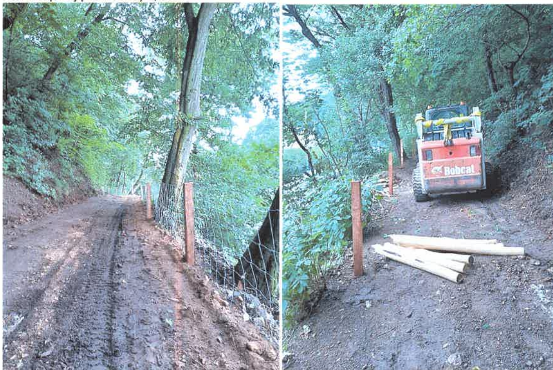
Obnova prvej promenády 5/2022
