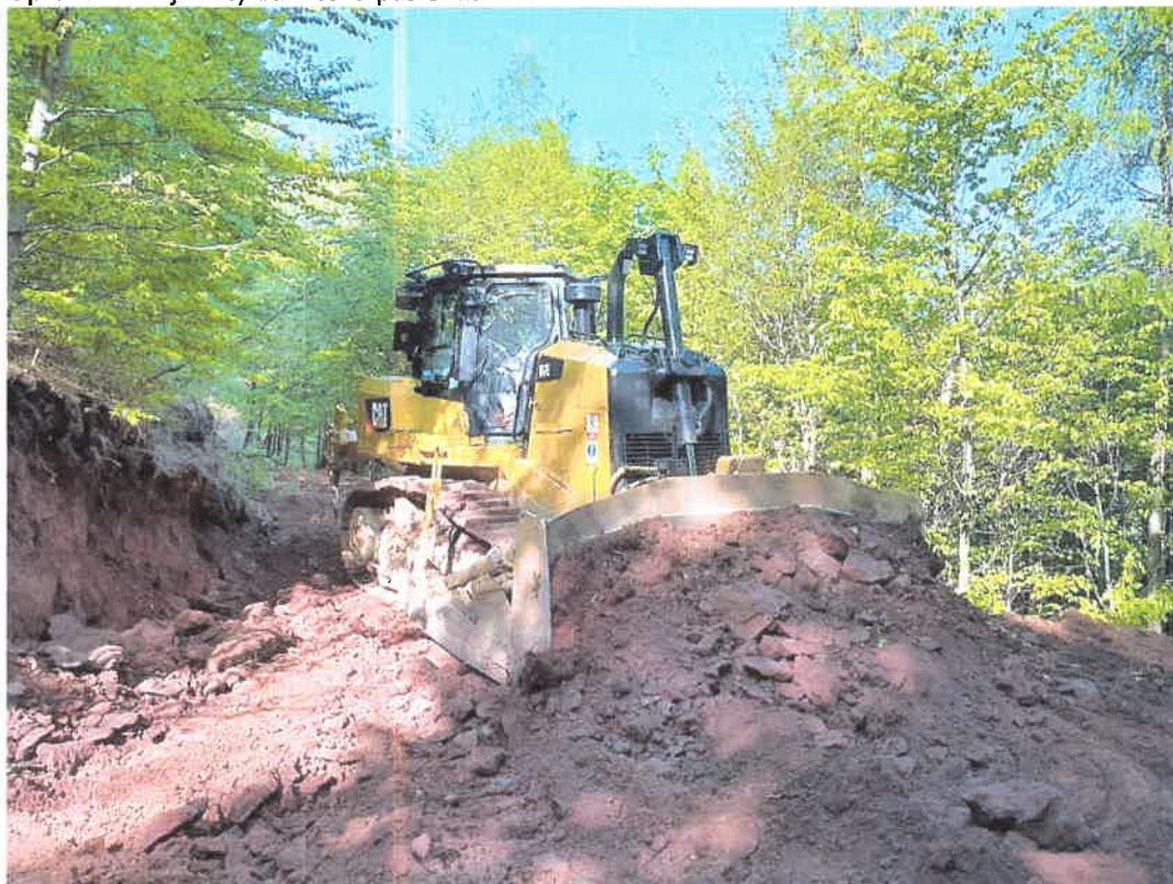
Oprava lesnej cesty Záhrbská pasienka
