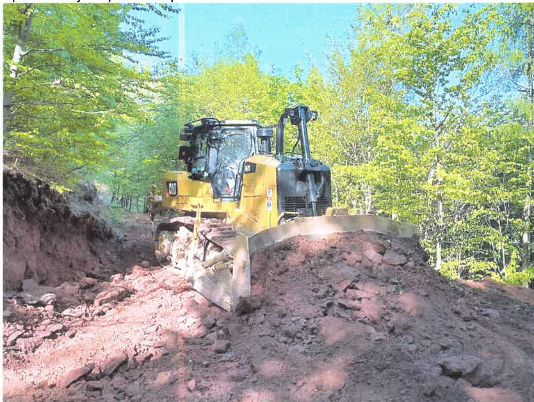
Oprava lesnej cesty Záhrbská pasienka
