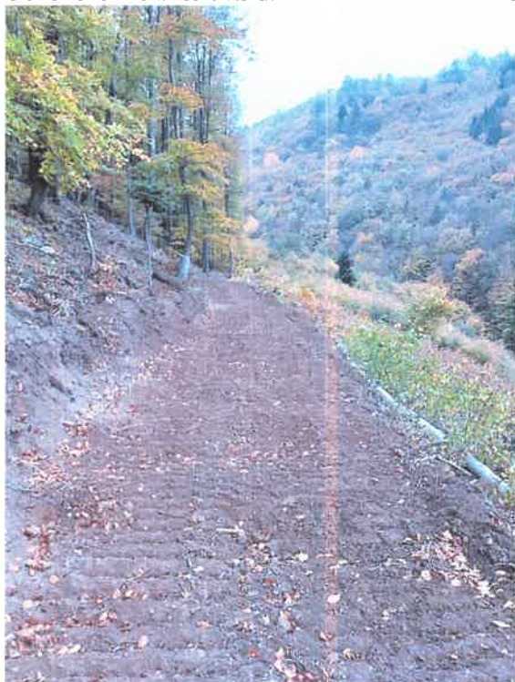
Obnovená zväžnica v Kaláni
